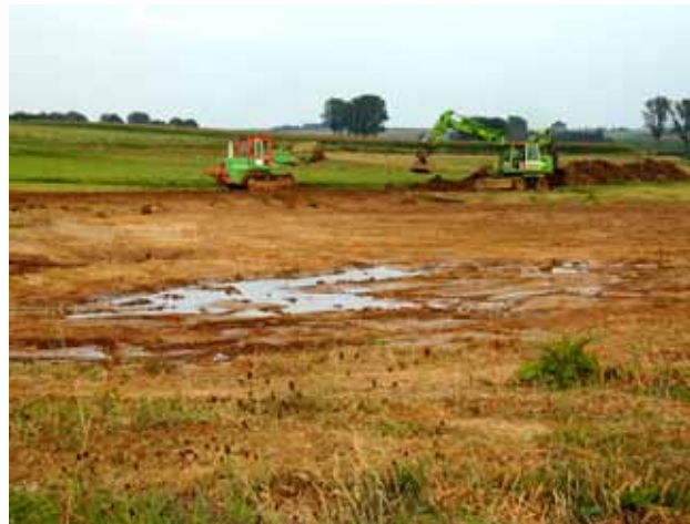
Verfüllung des Arzbachs 2002 (Foto: Könnemann)
