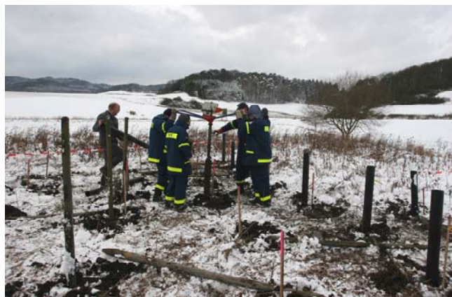
Fast 100 Bohrlöcher nehmen 175 kg Sprengstoff auf
