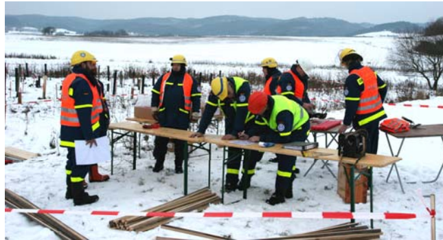
Gründliche Planung steht am Anfang einer Sprengung
