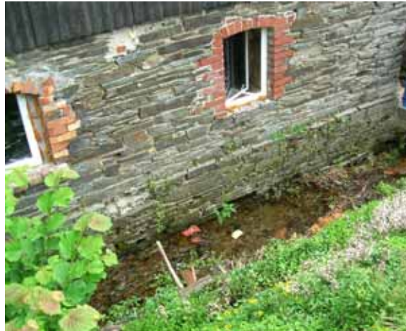
Ein Haus direkt am Gewässer - hier muss der Eigentümer sein Gebäude selbst schützen
