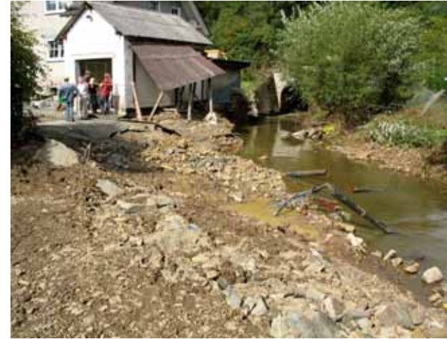
Ein Hochwasserschaden an Gebäude und Grundstück
