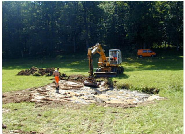
Das zur Verfüllung benötigte Material wurde aus der Nachbarschaft gewonnen, wodurch als zweite Maßnahme eine größere Grabentasche entstand. Diese dient nun im Frühjahr als Amphibienlaichgewässer. Durch die Verlegung des Lehrsbachs, die mit einer Sohlanhebung verbunden ist, werden die angrenzenden Auewiesen vernässen und wertvolle Feuchtlebensräume entstehen. Die Wiesen werden zukünftig während der Sommermonate extensiv mit Rindern beweidet. Ein Bewirtschafter hat sich bereits gefunden.
